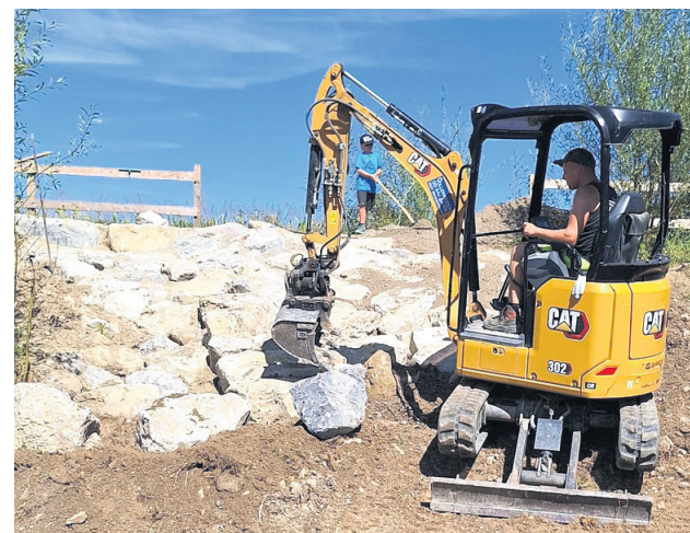
Der Bagger bringt die grossen Brocken in Position, es entsteht ein «Rock Garden» mit unterschiedlich anspruchsvollen Passagen.
